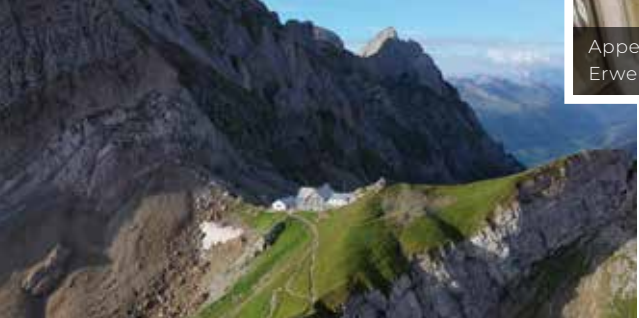
Berggasthaus Rotsteinpass, neue Fassade
